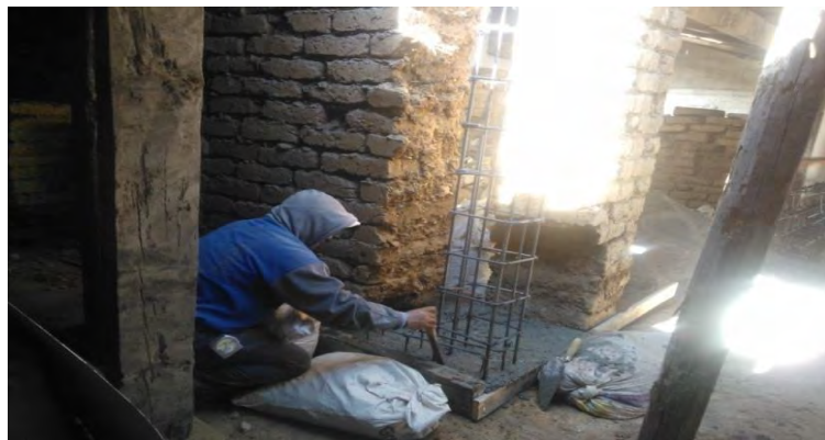
FOTOGRAFÍA 73: Alojamiento de acero y colado de espalón (QUIÑONES MONTES DE OCA, 2013)
