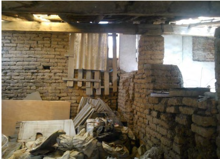
FOTOGRAFÍA 67: Terrado en su forma original (QUIÑONES MONTES DE OCA, 2013)
