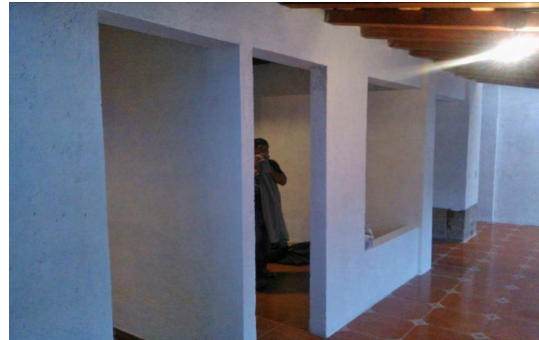
FOTOGRAFÍA 91: Pintado de muros (QUIÑONES MONTES DE OCA, 2013)
