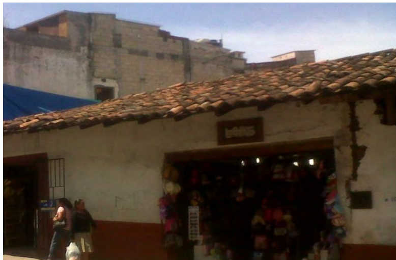
FOTOGRAFÍA 12: desplome en muro, fachada calle Benito Juárez (QUIÑONES MONTES DE OCA, 2013)
