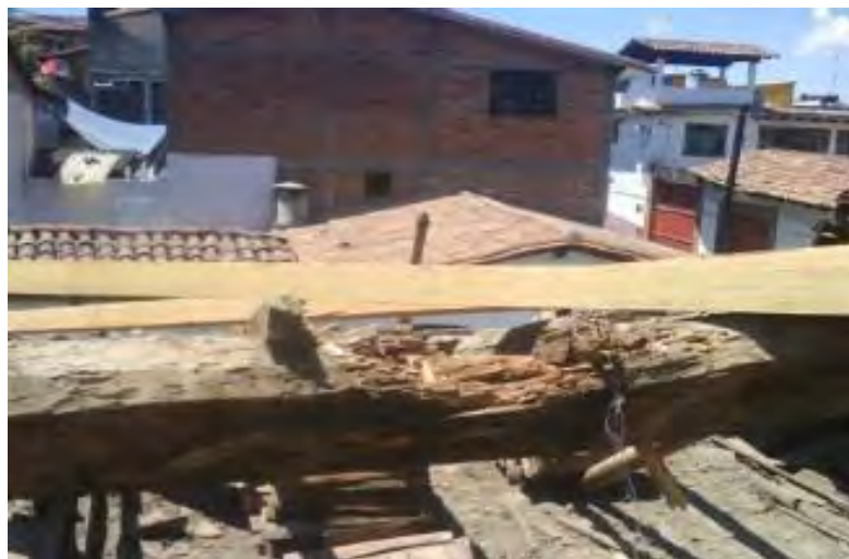
FOTOGRAFÍA 103: Retiro de maestras de madera, afectadas por el paso del tiempo (QUIÑONES MONTES DE OCA (2014)
