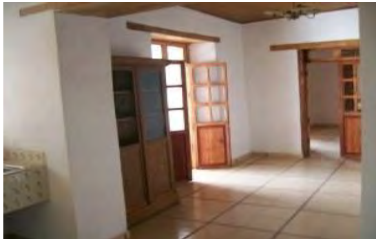
FOTOGRAFÍA 108: Colocación de loseta cerámica (QUIÑONES MONTES DE OCA (2014))
