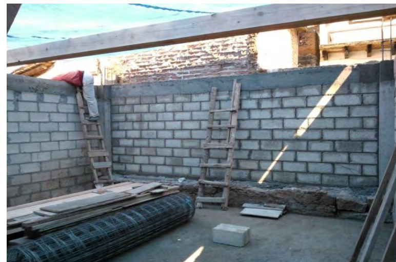
FOTOGRAFÍA 82: Colocación de Viga medianera, vista frontal (QUIÑONES MONTES DE OCA, 2013)
