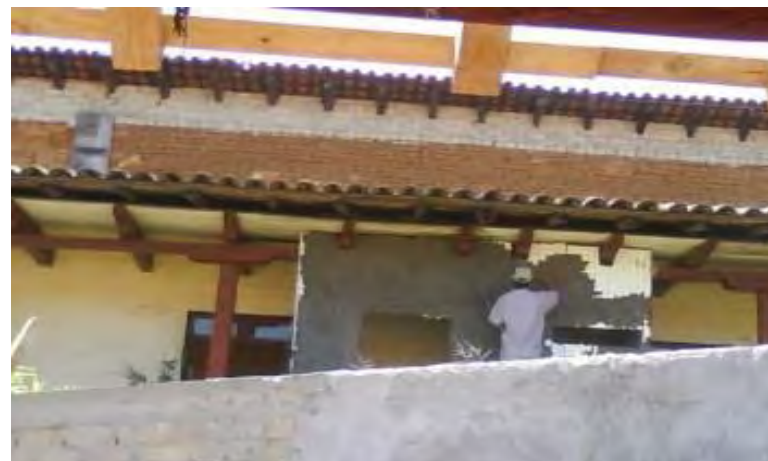
FOTOGRAFÍA 106: Aplanado de muros y detallado de plomos (QUIÑONES MONTES DE OCA (2014))
