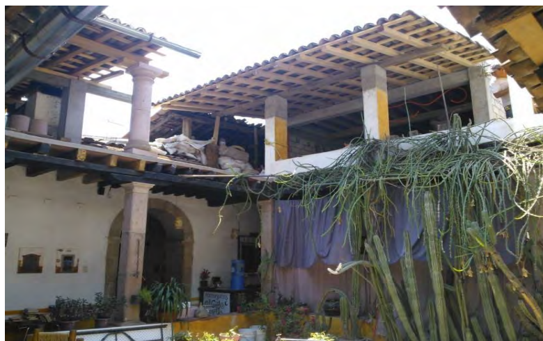
FOTOGRAFÍA 86: Vista desde planta baja con cubierta (QUIÑONES MONTES DE OCA, 2013)
