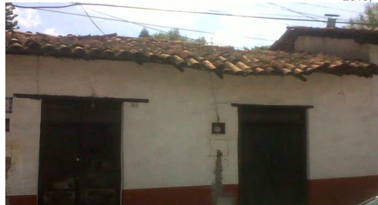
FOTOGRAFÍA 11: Fisuras en fachada perspectiva calle Monte alegre (QUIÑONES MONTES DE OCA, 2013)
