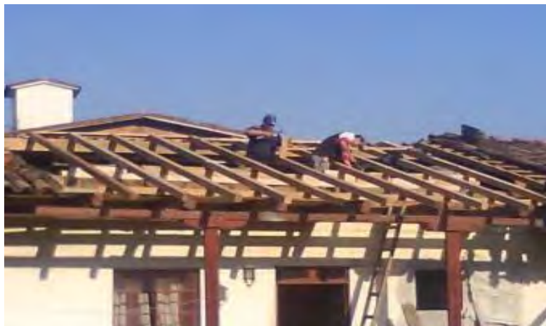
FOTOGRAFÍA 102: Retiro de Teja (QUIÑONES MONTES DE OCA L. , 2014)
