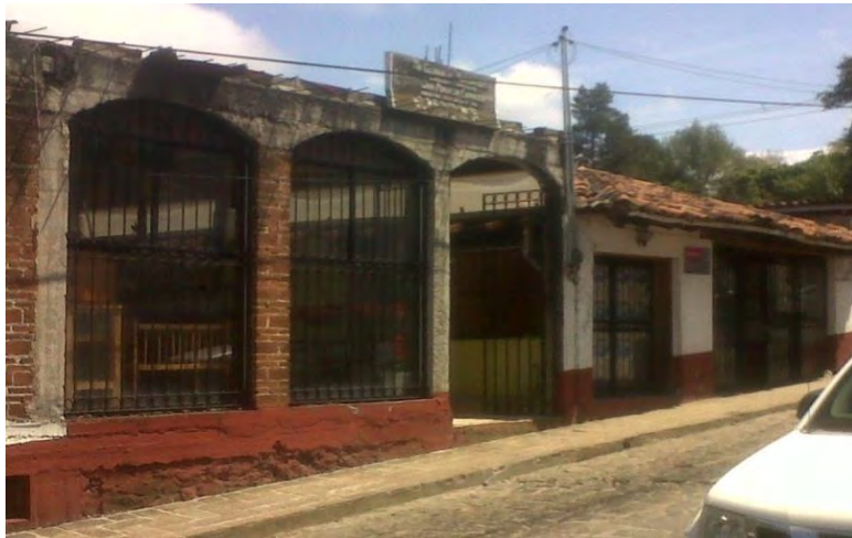
FOTOGRAFÍA 5: Fachada Comercio, calle Durango (QUIÑONES MONTES DE OCA, 2013)
