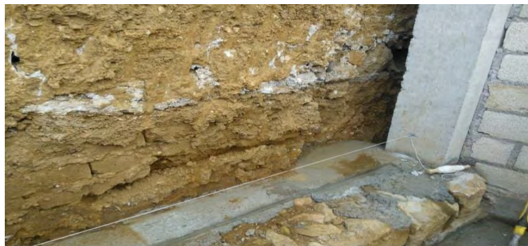
FOTOGRAFÍA 80: Desplante de muros en colindancia (QUIÑONES MONTES DE OCA, 2013)
