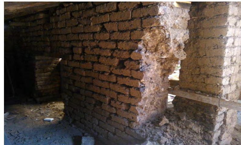
FOTOGRAFÍA 69: Abocardado de muro de adobe en uno de los puntos de mayor apoyo y dimensiones (QUIÑONES MONTES DE OCA, 2013)
