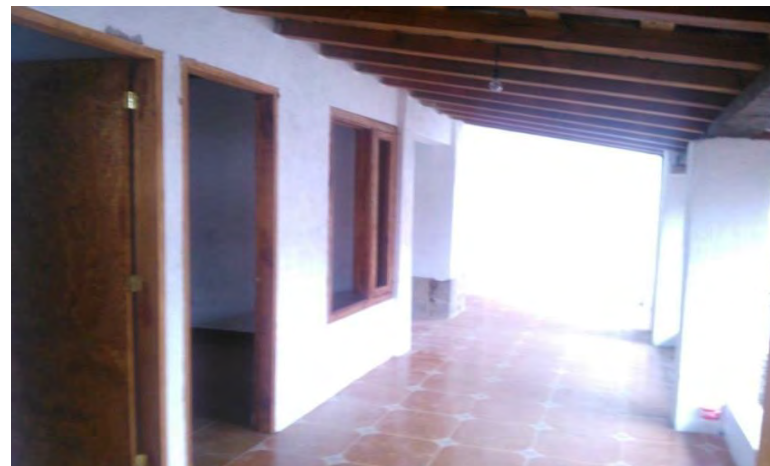
FOTOGRAFÍA 94: Colocación de puertas y ventanas en madera acabado en tintes cafés (QUIÑONES MONTES DE OCA, 2013)
