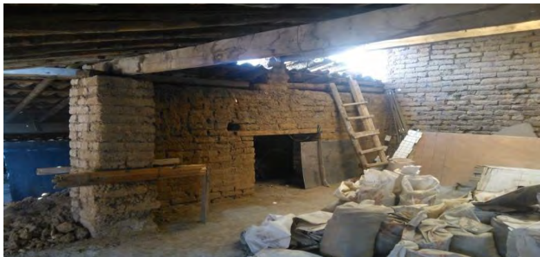
FOTOGRAFÍA 114: Caso 1 antes de intervención (QUIÑONES MONTES DE OCA L. A., 2013)
