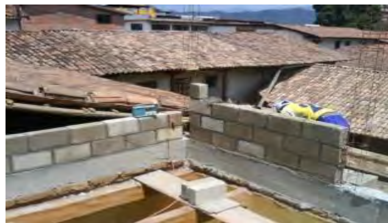
FOTOGRAFÍA 104: Desplante de muros sobre cadena armada, previamente al espolón en intersecciones (QUIÑONES MONTES DE OCA (2014)
