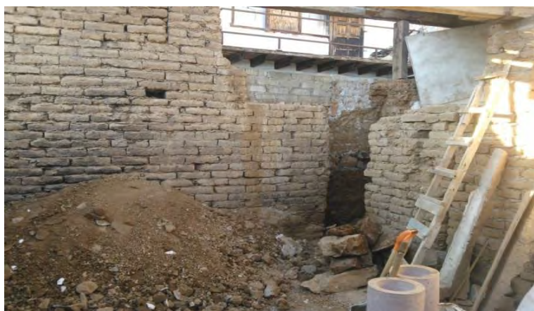
FOTOGRAFÍA 72: Abocardado de muros (QUIÑONES MONTES DE OCA, 2013)
