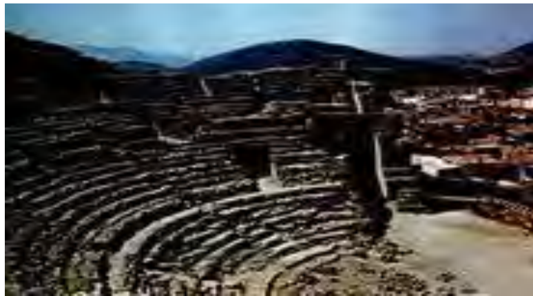
FOTOGRAFÍA 40: Teatro Romano Sagunto antes de la restauración. (Prieto, 2003)
