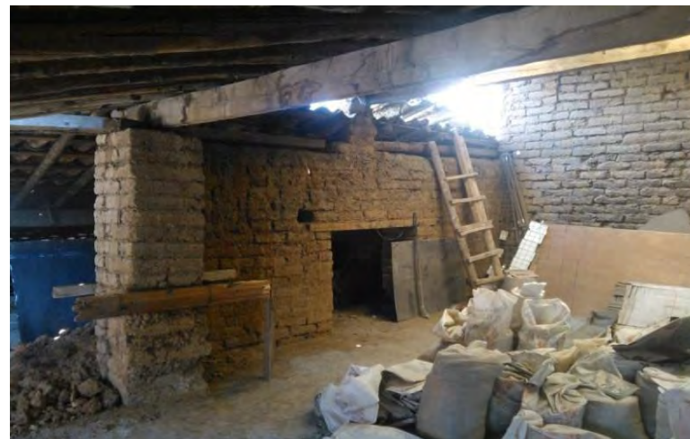
FOTOGRAFÍA 71: Terrado en su forma original (QUIÑONES MONTES DE OCA, 2013)
