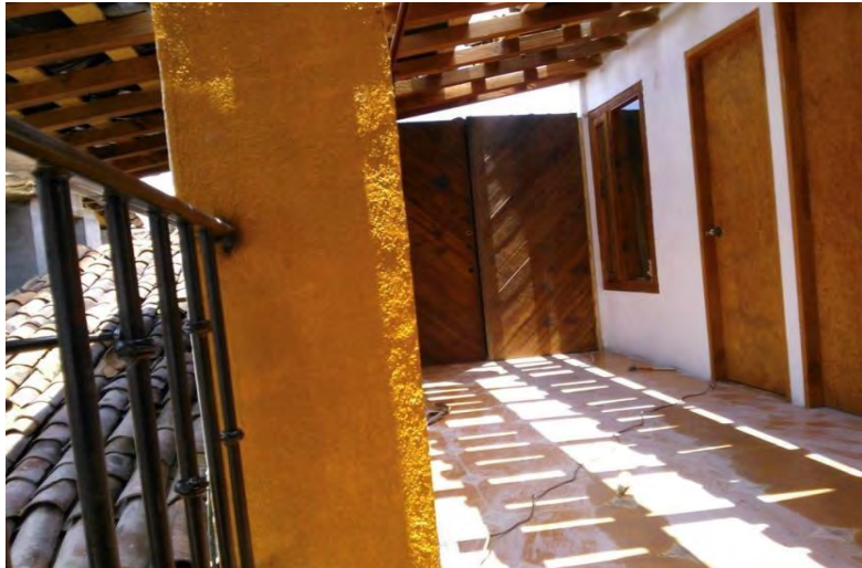
FOTOGRAFÍA 96: Intervención terminada (QUIÑONES MONTES DE OCA, 2013)
