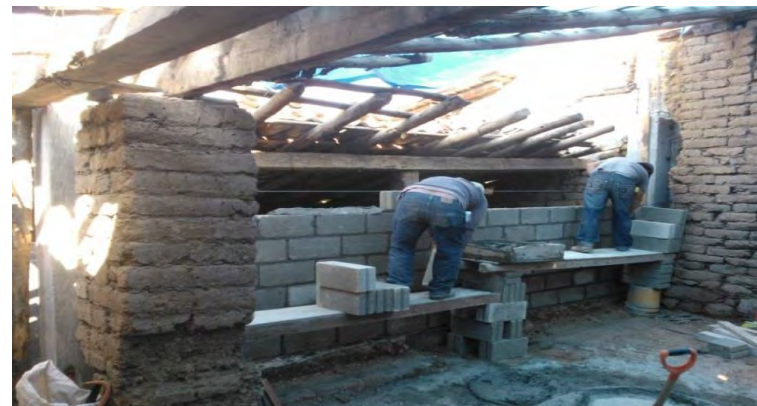
FOTOGRAFÍA 75: Colocación de muros con contacto al exterior (QUIÑONES MONTES DE OCA, 2013)
