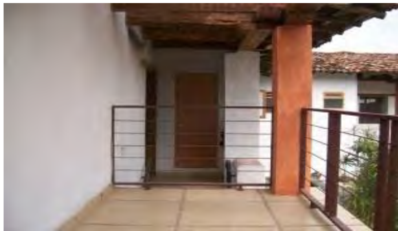
FOTOGRAFÍA 111: Exterior a la habitación que se elevó nivel (QUIÑONES MONTES DE OCA (2014))
