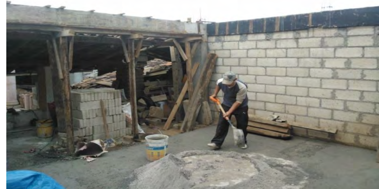
FOTOGRAFÍA 78: Trabajos de colado de trabe perimetral (QUIÑONES MONTES DE OCA, 2013)
