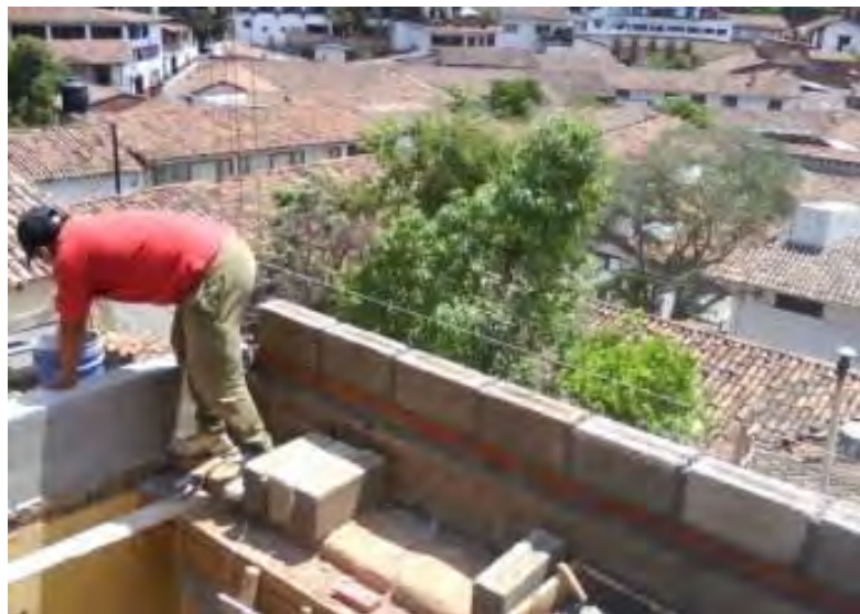
FOTOGRAFÍA 105: Desplante de muros al paño exterior (QUIÑONES MONTES DE OCA (2014))
