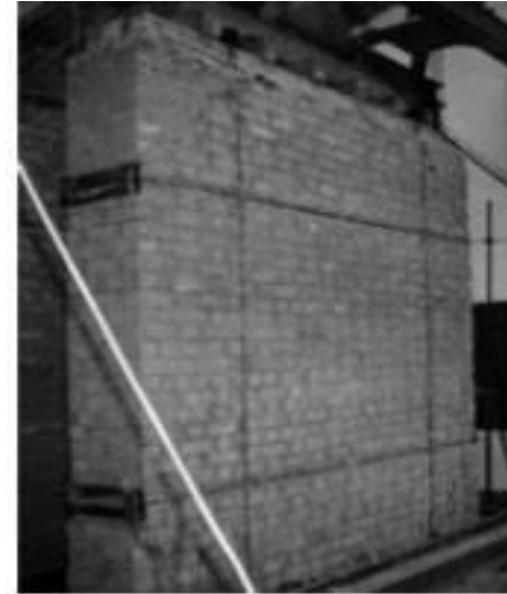
ILUSTRACIÓN 17: Muro de adobe con los refuerzos colocados (Díaz Ibarra, 2016)
