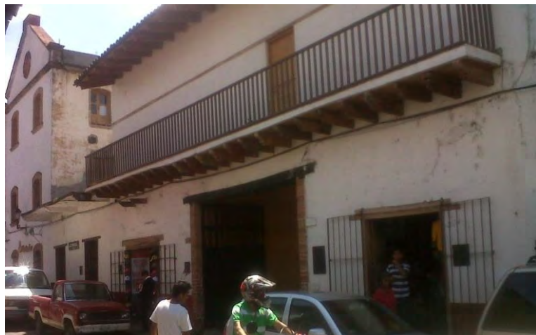
FOTOGRAFÍA 17: Trabe de madera vencida en acceso (QUIÑONES MONTES DE OCA, 2013)
