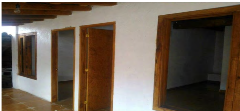
FOTOGRAFÍA 115: Caso 1 después de intervención (QUIÑONES MONTES DE OCA 2014)
