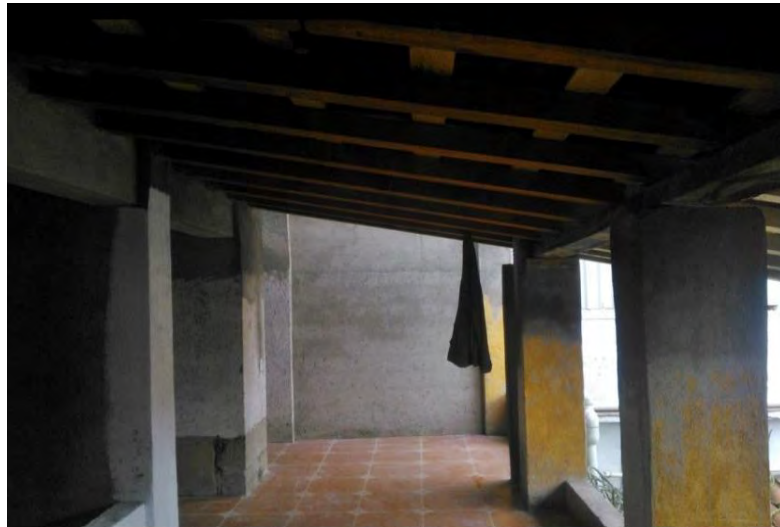
FOTOGRAFÍA 90: Colocación de loseta cerámica
