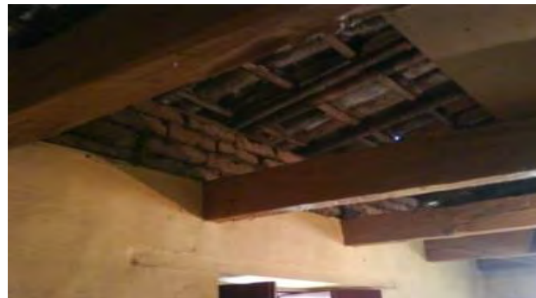
FOTOGRAFÍA 100: Interior de la habitación, donde se proyecta un nuevo nivel (QUIÑONES MONTES DE OCA (2014))
