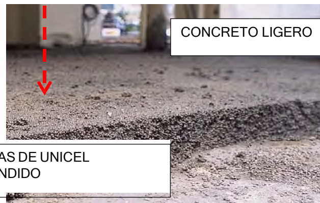
FOTOGRAFÍA 120: Colado con concreto aligerado a base de perlas de unicel.
