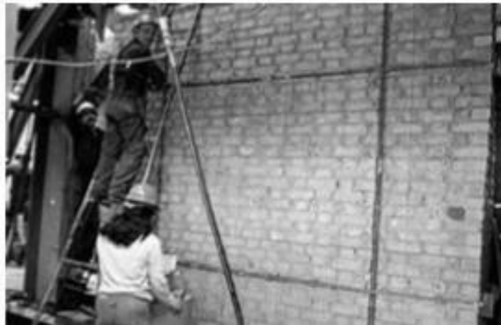
ILUSTRACIÓN 16: Pruebas de refuerzo en muros de adobe (Díaz Ibarra, 2016)
