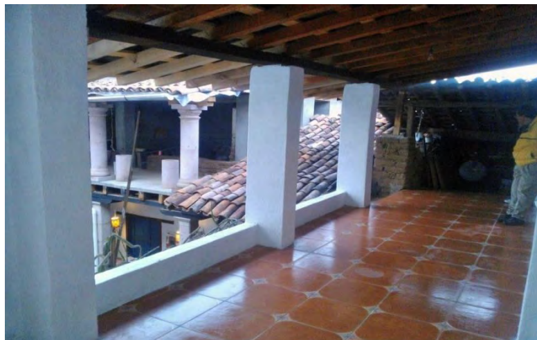
FOTOGRAFÍA 92: Pintado de muros (QUIÑONES MONTES DE OCA, 2013)
