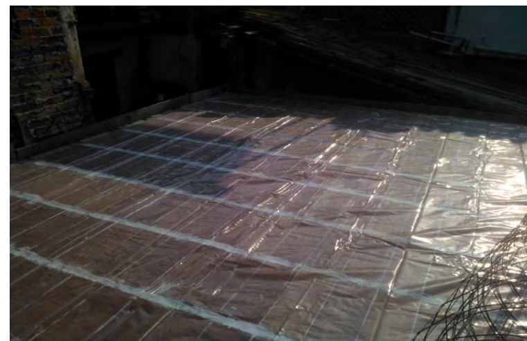
FOTOGRAFÍA 85: Colocación de plástico-impermeable para recibir concreto (QUIÑONES MONTES DE OCA, 2013)
