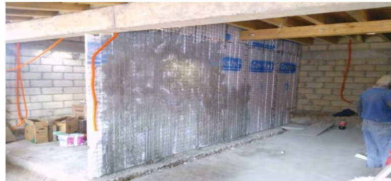
FOTOGRAFÍA 87: Muro de Panel de yeso (QUIÑONES MONTES DE OCA, 2013)
