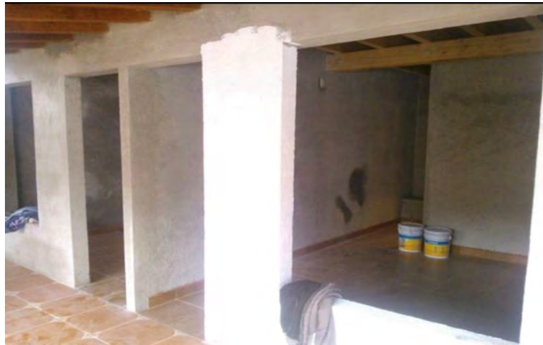
FOTOGRAFÍA 89: Colocación de loseta cerámica (QUIÑONES MONTES DE OCA, 2013)
