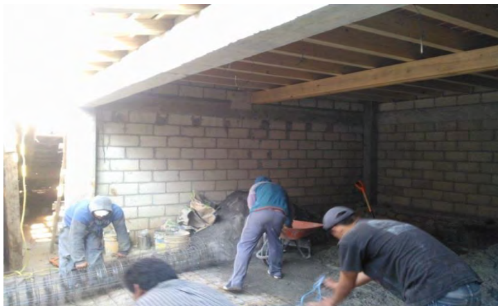
FOTOGRAFÍA 83: Cimbrado de losa de cubierta (QUIÑONES MONTES DE OCA, 2013)
