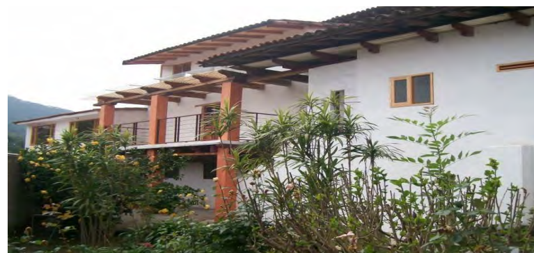
FOTOGRAFÍA 117: Caso 2 después de intervención (QUIÑONES MONTES DE OCA 2014)
