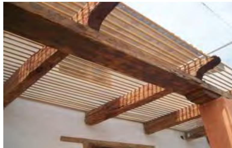
FOTOGRAFÍA 112: Cubierta en terraza de cristal sobre envigado existente tratado (QUIÑONES MONTES DE OCA (2014))
