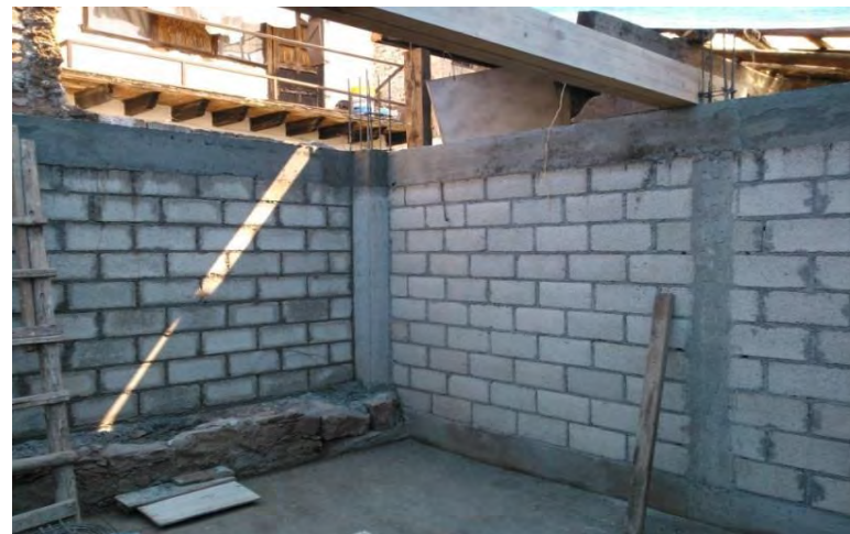
FOTOGRAFÍA 81: Colocación de Viga medianera, vista lateral (QUIÑONES MONTES DE OCA, 2013)
