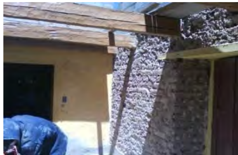
FOTOGRAFÍA 101: Escarificación de muros (QUIÑONES MONTES DE OCA (2014))
