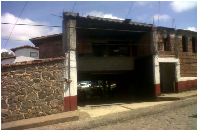
FOTOGRAFÍA 4: Fachada Comercio, calle Durango (QUIÑONES MONTES DE OCA, 2013)
