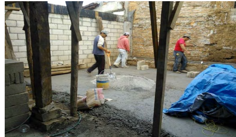
FOTOGRAFÍA 79: Trabajos de firme de concreto ligero (QUIÑONES MONTES DE OCA, 2013)
