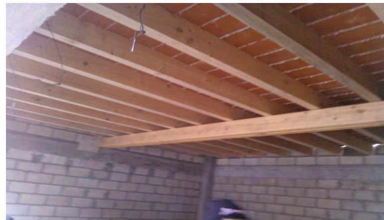
FOTOGRAFÍA 84: Plafón a base de solera de barro y envigado de madera (QUIÑONES MONTES DE OCA, 2013)
