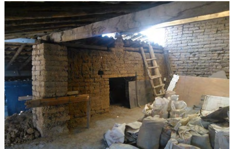
FOTOGRAFÍA 66: Terrado en su forma original (QUIÑONES MONTES DE OCA, 2013)
